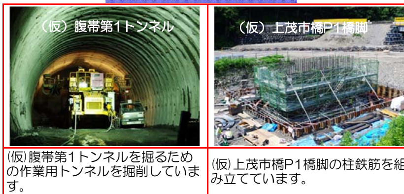
①施工：戸田・岩田地崎JV
